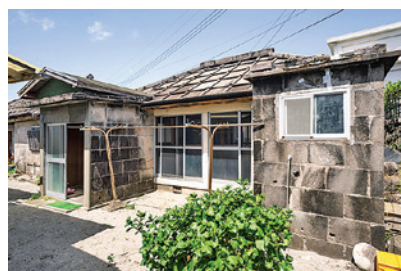
宿泊施設に改修予定のコーガ石でできた建屋☆
